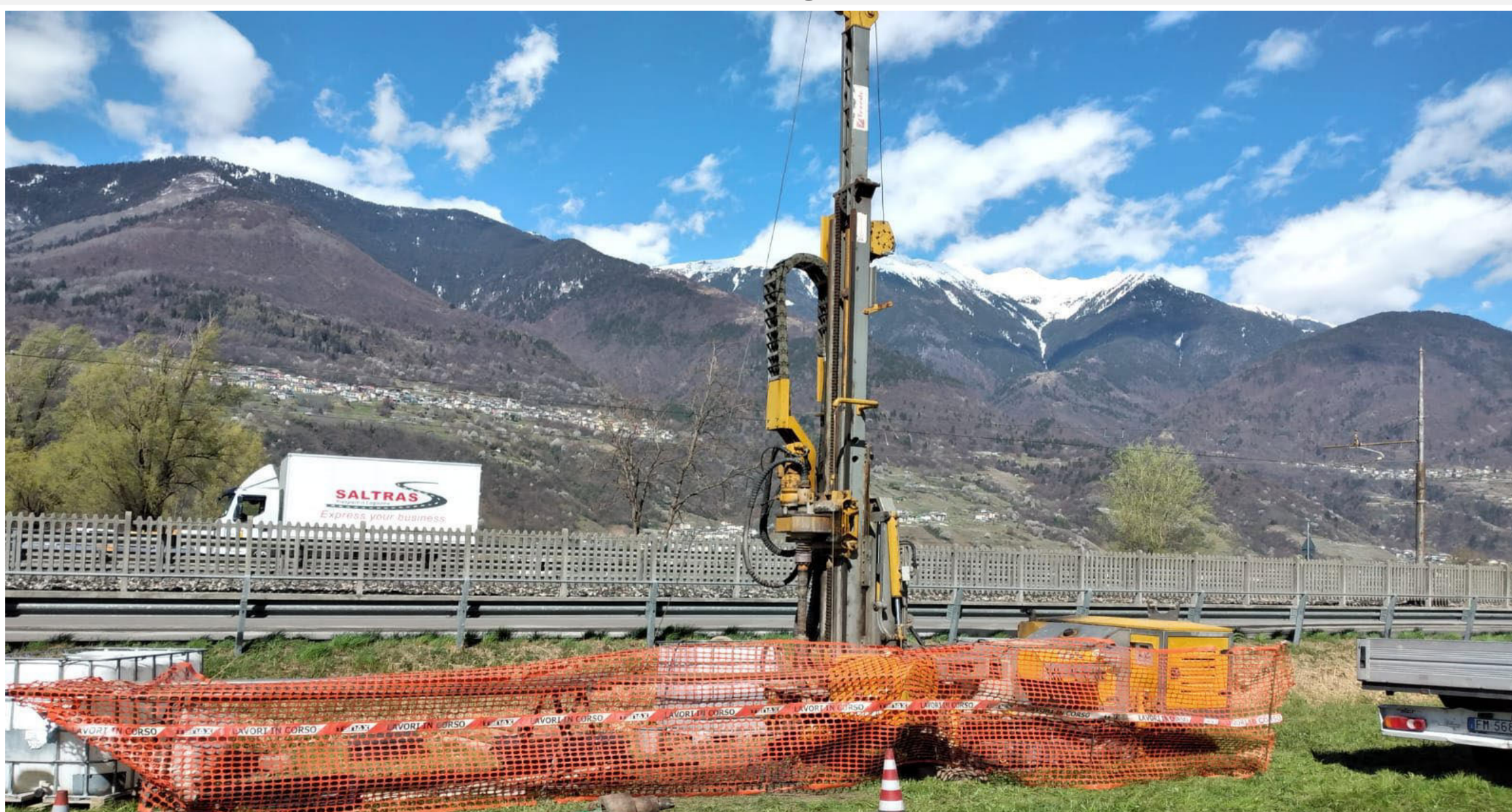
Postazione SONDAGGIO S1-DH
